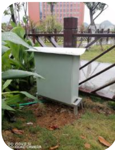
荷花池雾化器安装
