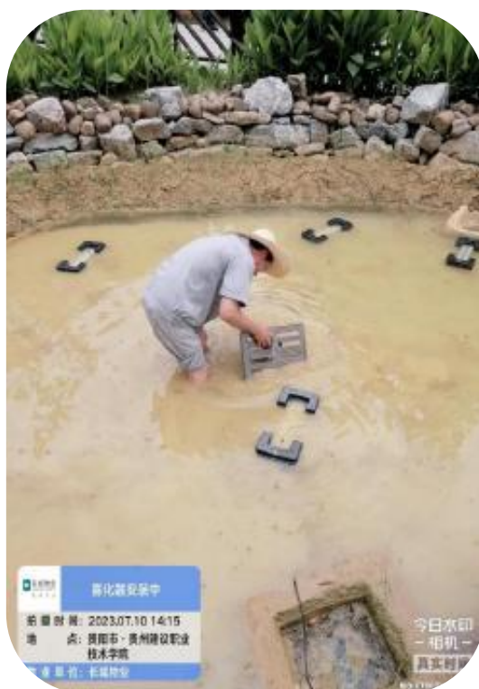
荷花池雾化器安装调试
