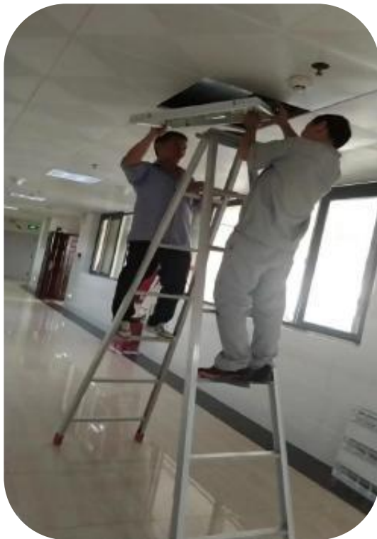
教学楼过道灯具更换
